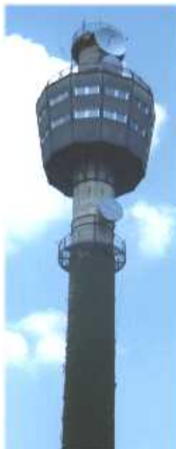
Antenne di test dei ponti radio sulla antica torre della Telettra a Vimercate
