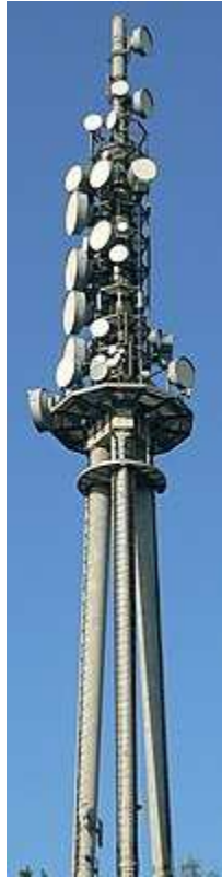
Antenne di Ponti Radio a Stoccarda
