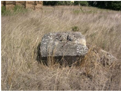
Uno dei plinti dei tralicci dell'Aereo
